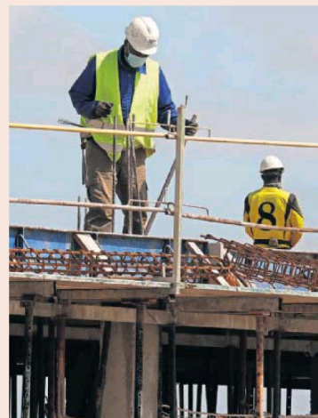
Dos trabajadores en una obra. PABLO MONGE
