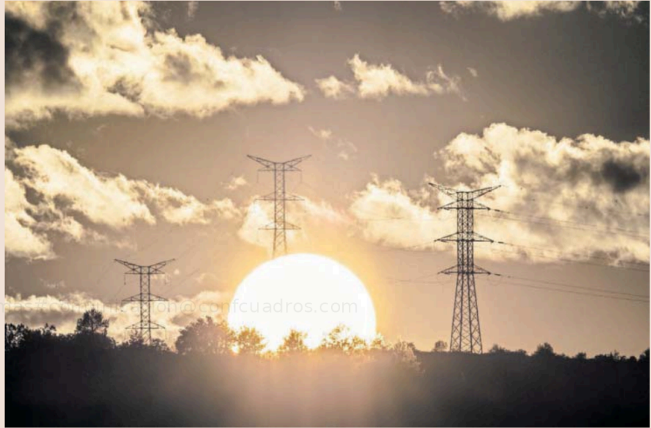
Una torre eléctrica junto a una estación de alta tensión en Benejama (Alicante). GETTY IMAGES
