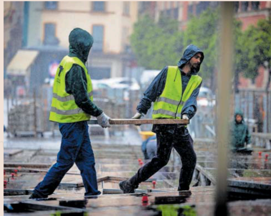
Un grupo de operarios trabaja en una obra en Sevilla. PACO PUENTES
