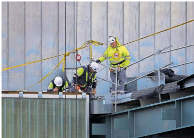
Trabajadores en un obra en Santiago de Compostela. ÓSCAR CORRAL
