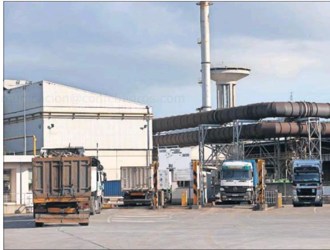
La planta de Megasa ubicada en Narón (A Coruña), el pasado martes. / KIKO DELGADO (EFE)
