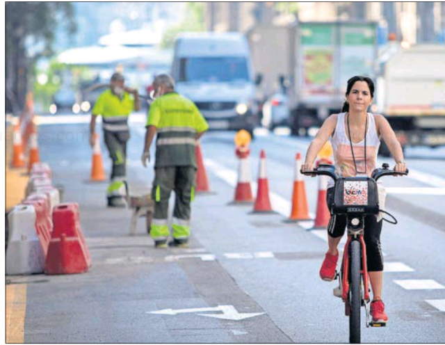
Obras para un carril bici en la Vía Laietana de Barcelona en mayo de 2020. / MASSIMILIANO MINOCCI
