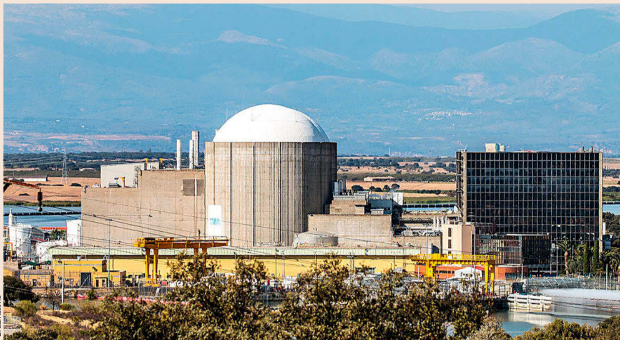
Central nuclear de Almaraz, en Cáceres (Extremadura).
