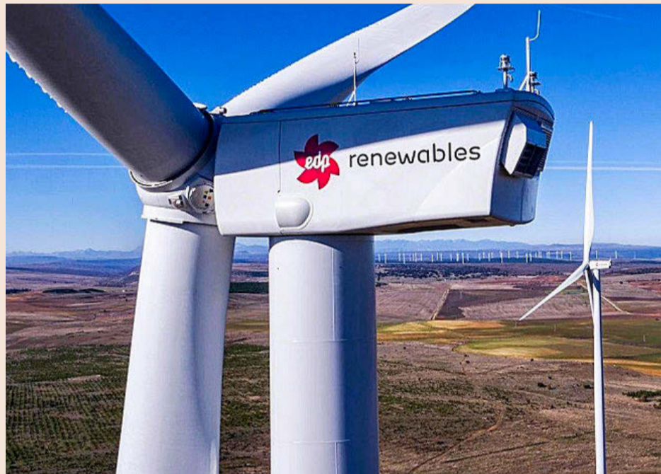
Aerogeneradores de EDPR en Quintanilla (Burgos).
