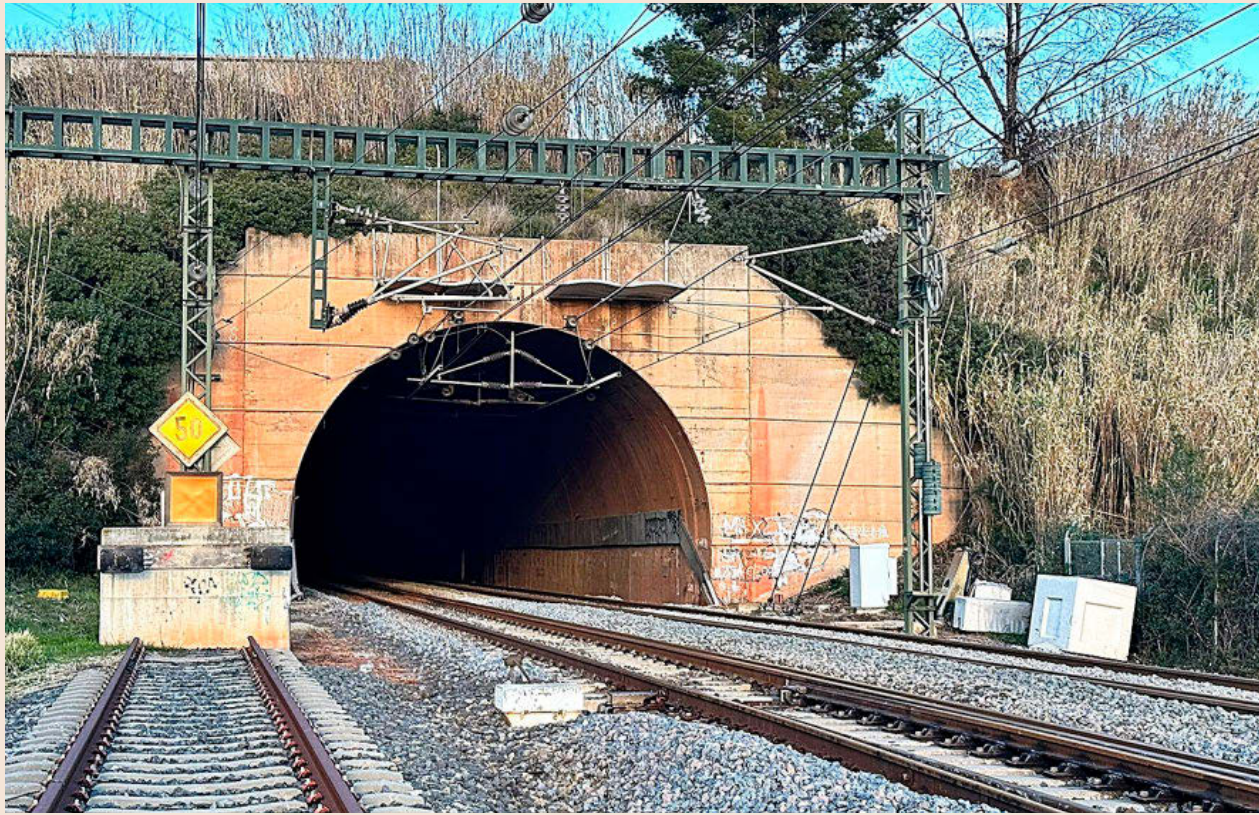
El túnel de Adif en Rubí, que reabrió ayer al tráfico y donde continuarán las labores de mantenimiento.
