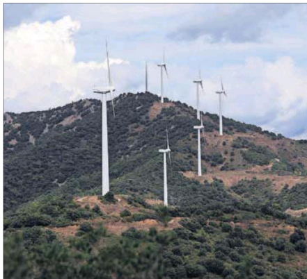
Parque eólico de Collet dels Feixos (Tarragona). / JOSEP LLUIS SELLARÉ
